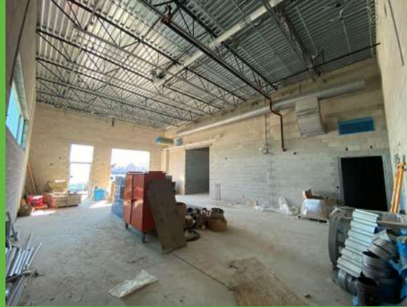
Atelier de construction
