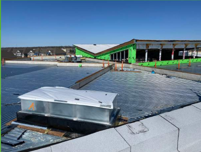
Toit à claire-voie au dessus de la bibliothèque et atrium
